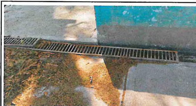
Foto 3: Reparación de cunetas de concreto
