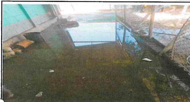
Foto 1: Sustitución de tubería pvc línea principal aguas pluviales.
