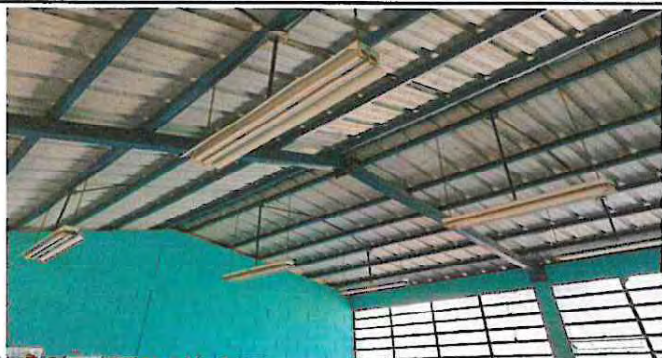
Foto1: Reparación de sistema eléctrico en las aulas.
