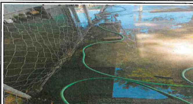
Foto 2: Sustitución de tubería pvc línea principal aguas pluviales.
