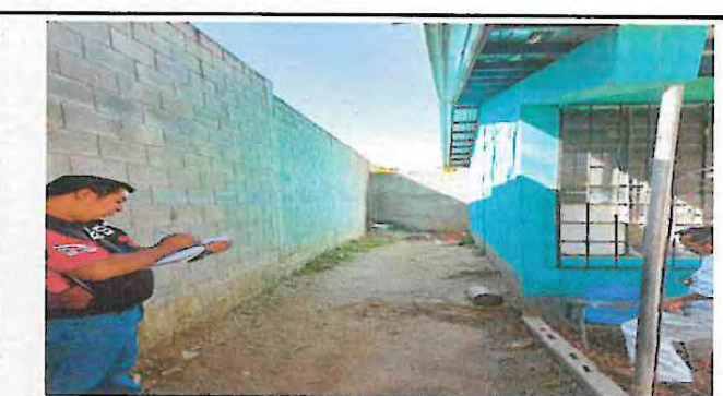
Foto 6: Colocación de lamina troquelada en bodega y puerta.
