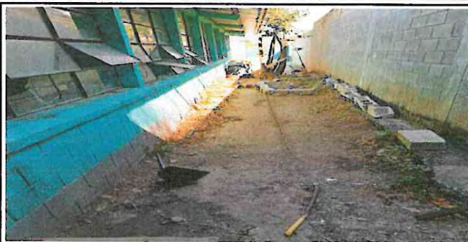
Foto1: Sustitución de patio de tierra por pavimento.
