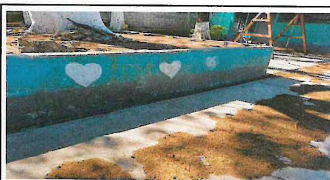
Foto 4: Reparación de cunetas de concreto.
