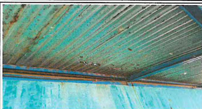
Foto 2: Sustitución de lamina por lamina troquelada de alucin para escenario.
