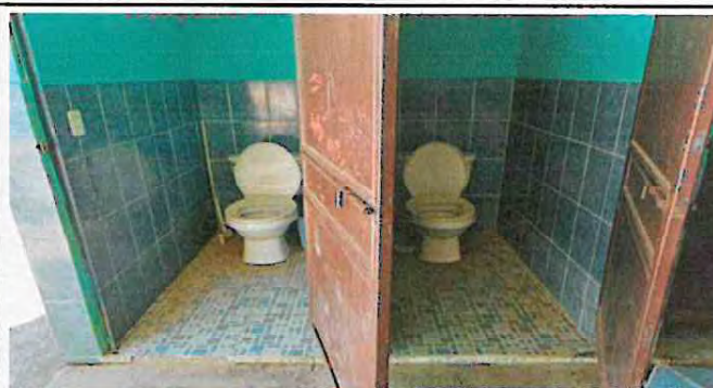
Foto 2: Sustitución de accesorio para sanitarios.
